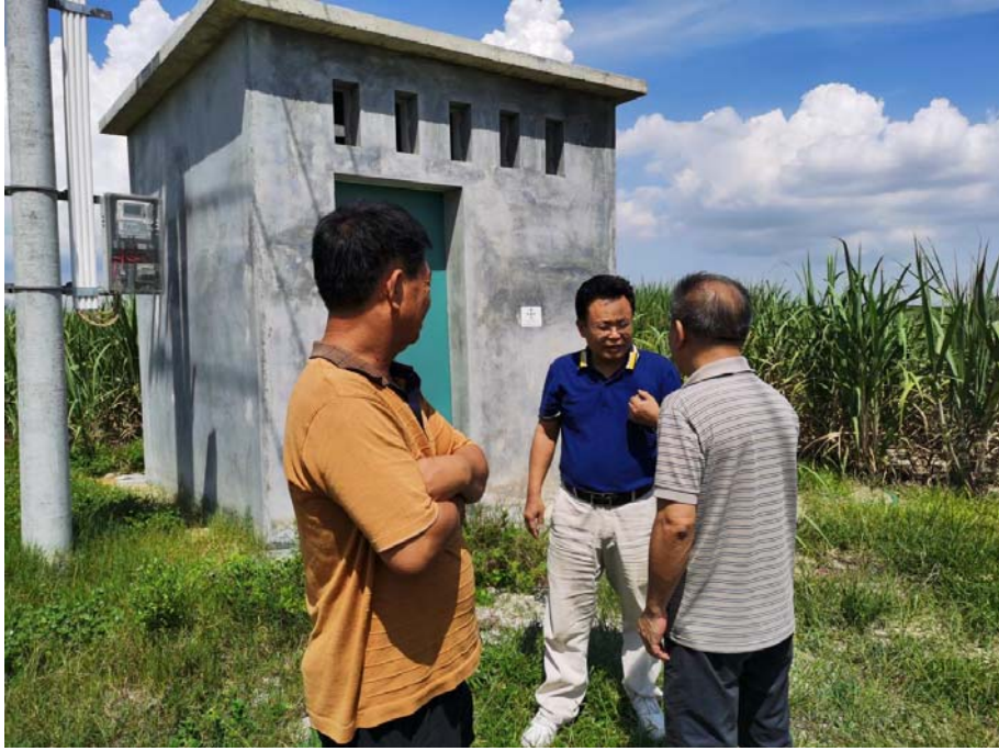
检查组实地查看龙眼村农田抗旱井设施情况
