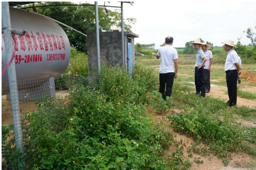
检查组实地查看甘来村供水设施情况
