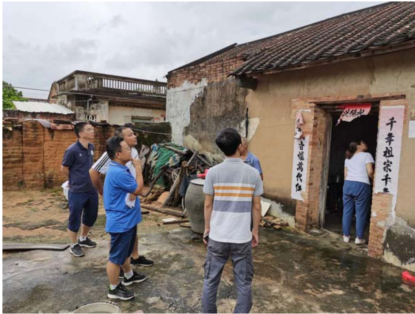
调研组实地检查苏二村住房困难户房屋修缮工作
