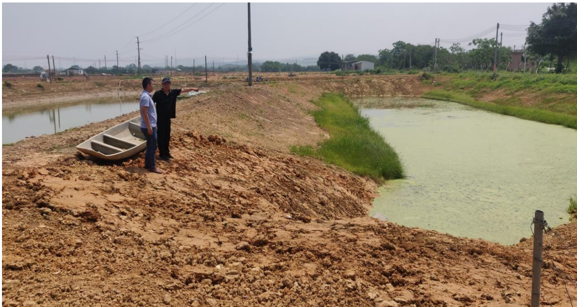
合洋水产有限公司检查现场
