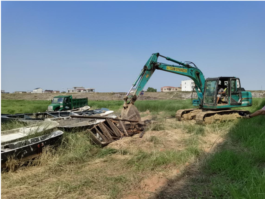
挖掘机对大塘镇一批涉渔“三无”船舶进行清拆现场
