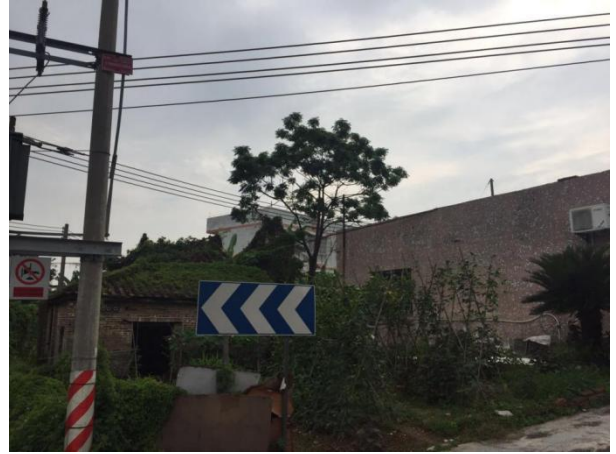
项目南面（部分废弃楼房）
