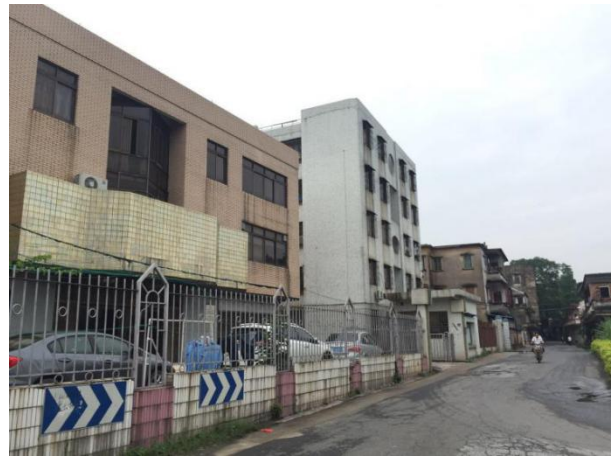
项目北面（废弃供电所及居民区）
