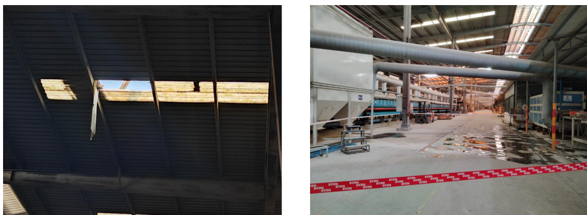
（左图为事发后顶棚透光瓦破损处，右图为朱英岗坠落成型二车间地面位置）
