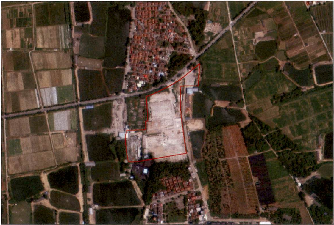
图 3 拆除后场地照片
