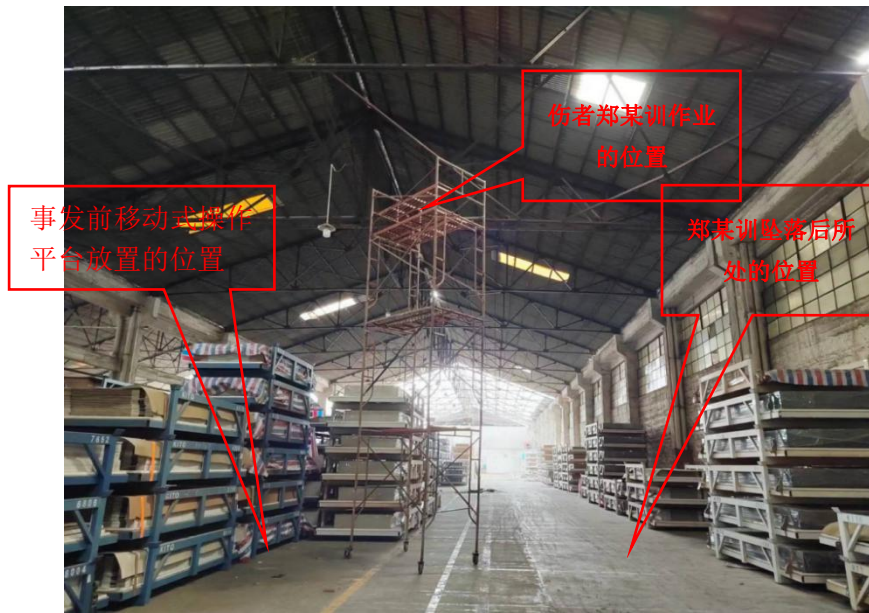
图一：事发现场概貌（一），上述移动式操作平台为还原事故现场而搭设的与涉事移动式操作平台同一规格及高度的操作平台。
