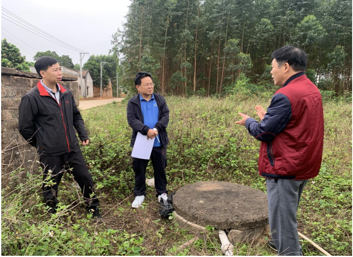
翁汉仕副局长一行实地调研余村村安全饮用水工程情况
